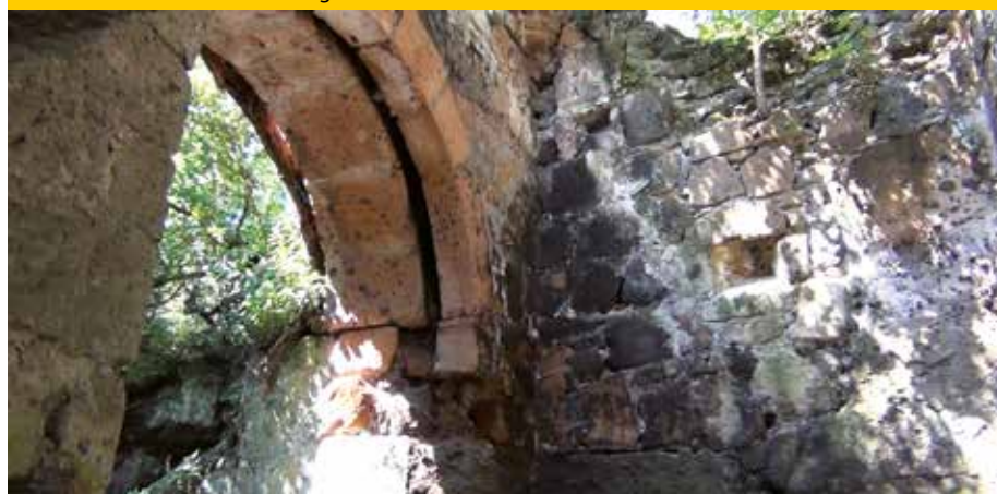
La torre nord del Castello di Fogliano
